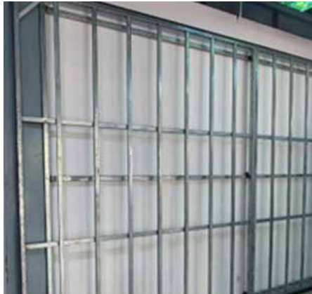
Siapkan Dinding dan Rangka Videotron
