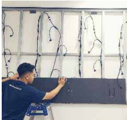
Pasang Module, Kabel Network dan kabel power
